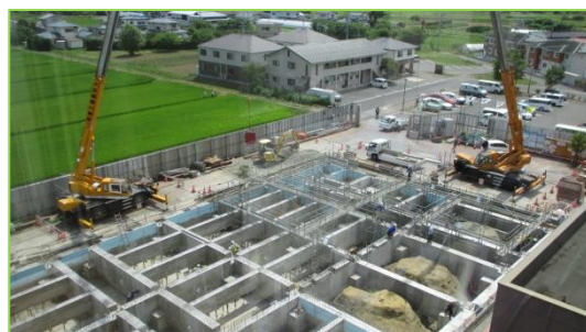
結核医療提供施設増築工事進捗状況 (H30/8/2撮影)
